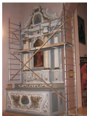
Restauration des retables de l'église de la Hoube (57)
